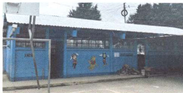
Foto 2: Sustitución de lámina, por lámina troquelada aluzinc calibre 26 Módulo I
