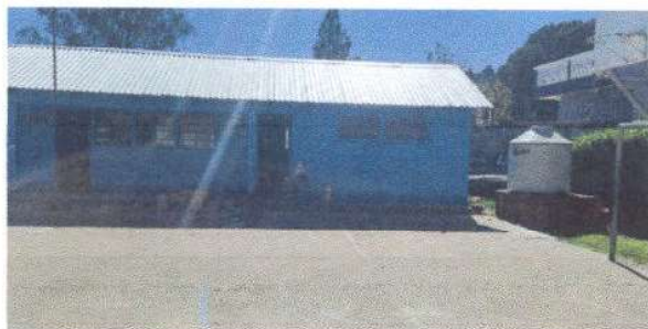
Foto 1: Sustitución de lámina, por lámina troquelada aluzinc calibre 26 Módulo II
