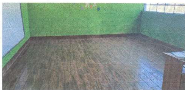
Foto 3: Sustitución de piso de cemento líquido por piso cerámico en aula Módulo I
