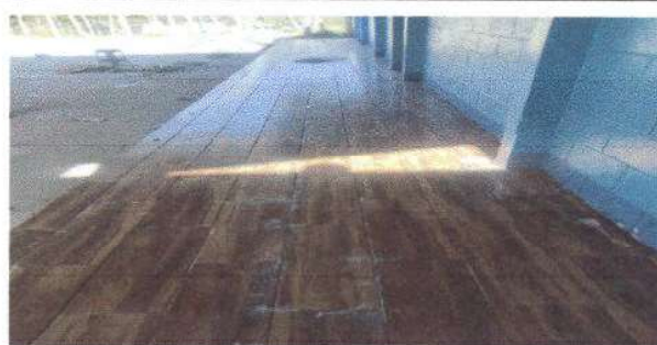
Foto 5: Sustitución de piso de cemento líquido por piso cerámico en Corredor Módulo I
