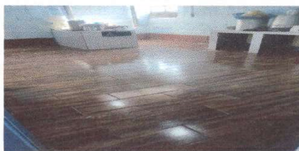
Foto 6: Sustitución de piso de cemento líquido por piso cerámico en Cocina
